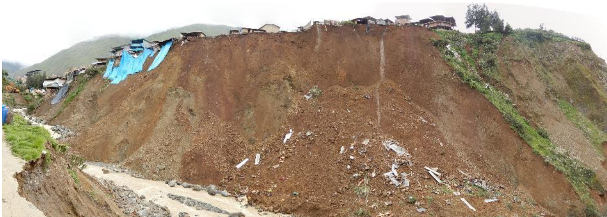
Fotografía 6. Múltiples derrumbes producido en el lado norte del depósito run up (se exponen viviendas en el acantilado)
