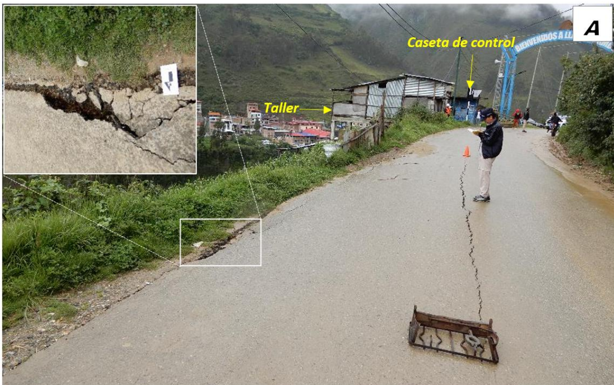
Figura 9. Agrietamientos longitudinales en la vía asfaltada de ingreso a Llacuabamba.
