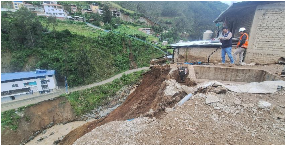
Fotografía 7. Vista de viviendas con paredes agrietadas, en el límite de la zona de arranque, las cuales están a punto de colapsar.
